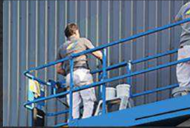
Rafraîchissement & rénovation de bardages métalliques
