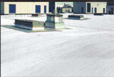
Rénovation d'une toiture complète
