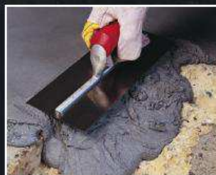
RÉPARATION DU BÉTON
