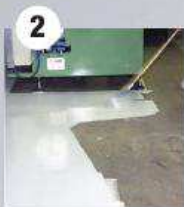
2 Appliquer du revêtement pour sols 7100
